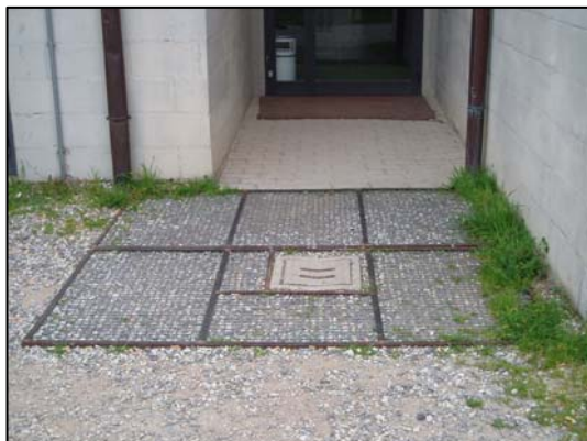
foto 8: particolare dell'ingresso alla palestra pubblica in via Coppi, nel Capoluogo. La presenza di un grigliato a maglie larghe e del chiusino rappresenta un evidente ostacolo alla mobilità.
