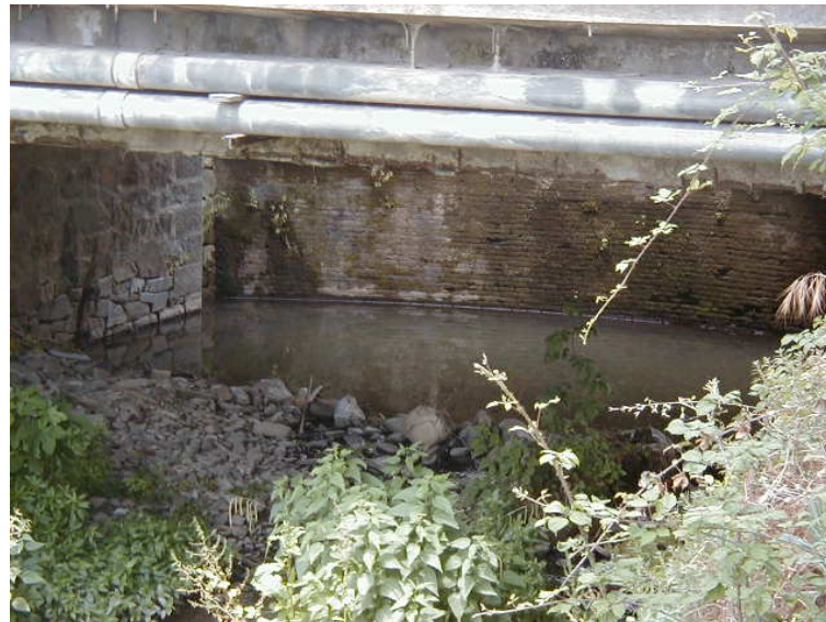
Foto 42 – T. Settola: briglia sotto il ponte di via IV Novembre
