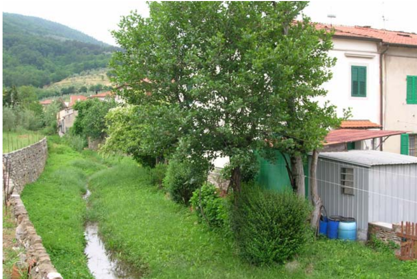
Foto 29 – T. Settola: tratto a monte della sezione SE2025__
