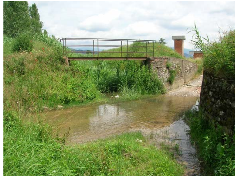
Foto 86 – T. Settola: guado e passerella visti da valle
