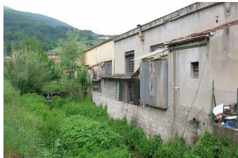
Foto 28- T. Settola: tratto a monte della sezione SE2024__
