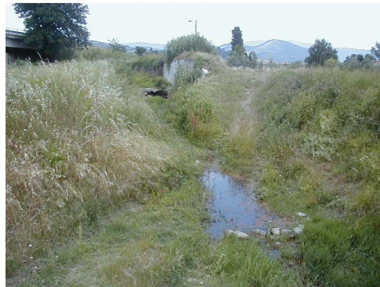
Foto 72 - T. Settola: tratto a valle della briglia SE2070B_
