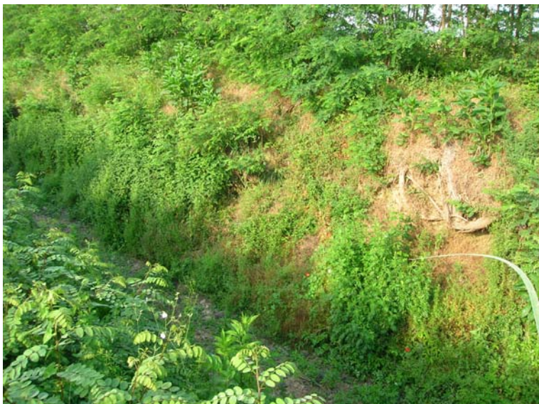
Foto 119 - T. Settola: argine dx alla sezione SE2110__
