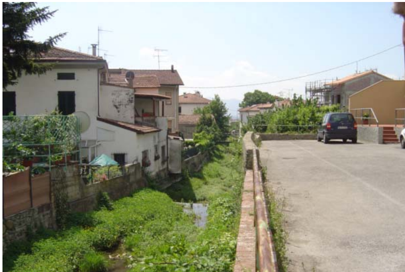
Foto 33 – T. Settola: tratto a valle del ponte di via Nerucci
