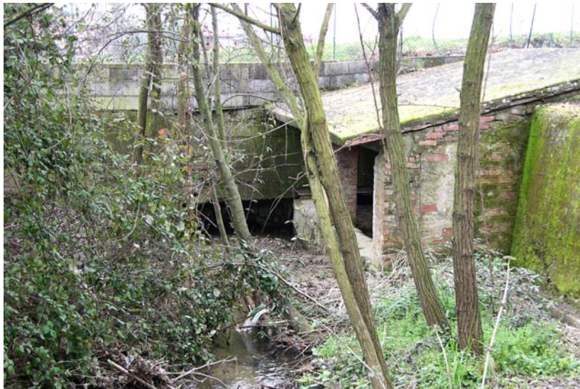
Foto 1 – F. Badia: ponte su via Fonte Bronia visto da monte (sez. BA0002A_)
