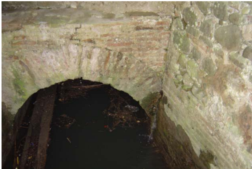
Foto 13 – F. Agnaccino: ingresso del sottoattraversamento del T. Agna
