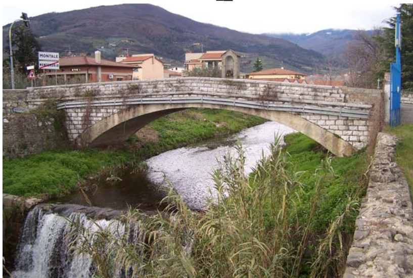
Foto 19- T. Agna: ponte su via Montalese visto da valle (sez. AG0013C_)
