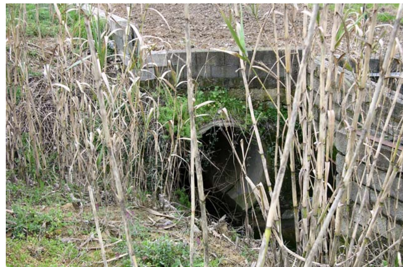
Foto 8- Badia: fine tratto tombato in corrispondenza della sezione BA0005C_
