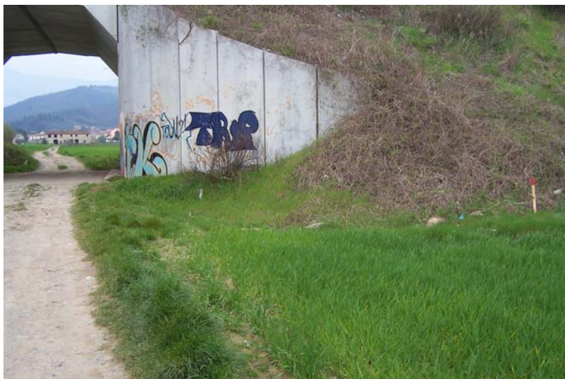
Foto 21 - T. Agra: sottopasso di via Berlinguer posto in sx idrografica del ponte alla sezione AG0014B_
