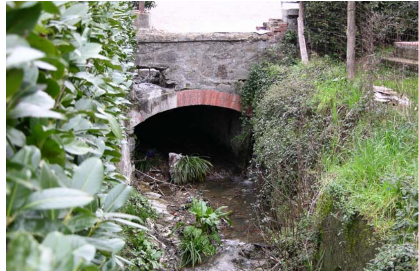
Foto 10 - Badia: fine tratto tombato in corrispondenza della sezione BA0006C_
