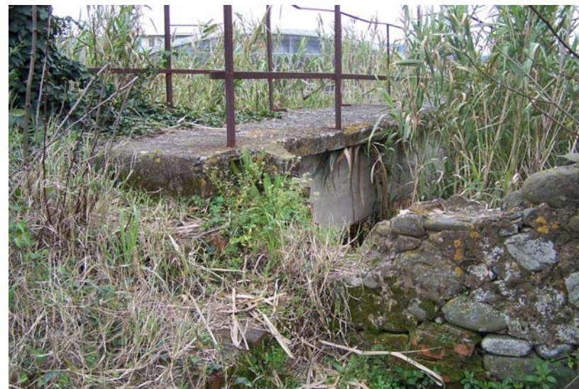
Foto 26 - T. Agna: passerella in corrispondenza della sezione AG0015B_
