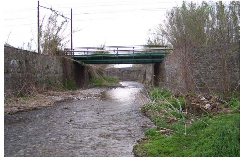
Foto 30 - T. Agna: ponte su via Pistoiese visto da valle (sez. AG0016C_)
