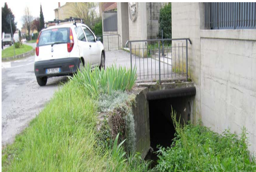
Foto 7 – F. Mulini: attraversamento alla sezione FM0032B_ (a monte)
