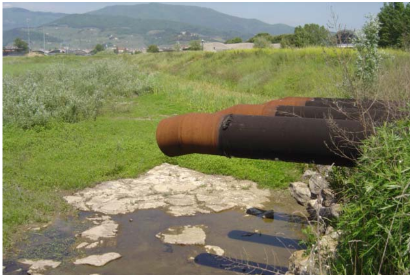
Foto 5 – F. Agnaccino: area della cassa di espansione
