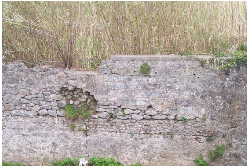
Foto 29 - T. Agna: muro di sponda nei pressi del ponte di via Pistoiese (sez. AG0016C_)
