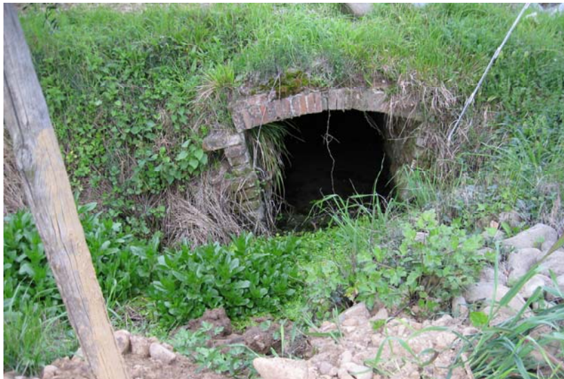
Foto 1 – F. Mulini: sezione a chiusura di tratto tombato alla sezione FM0011C__
