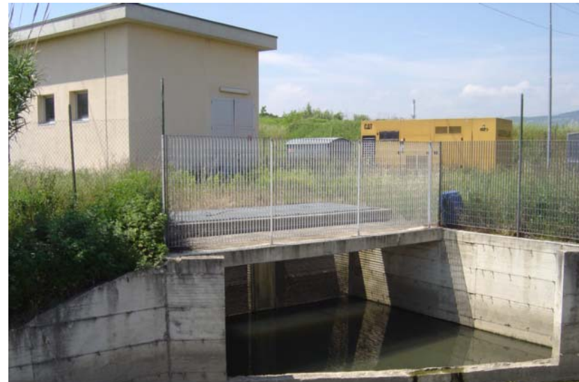
Foto 2 - F. Agnaccino: impianto di sollevamento della cassa di espansione
