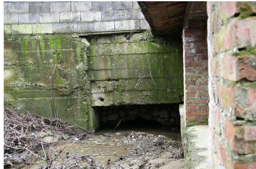
Foto 2 - Badia: ponte su via Fonte Bronia visto da monte (sez. BA0002B_)
