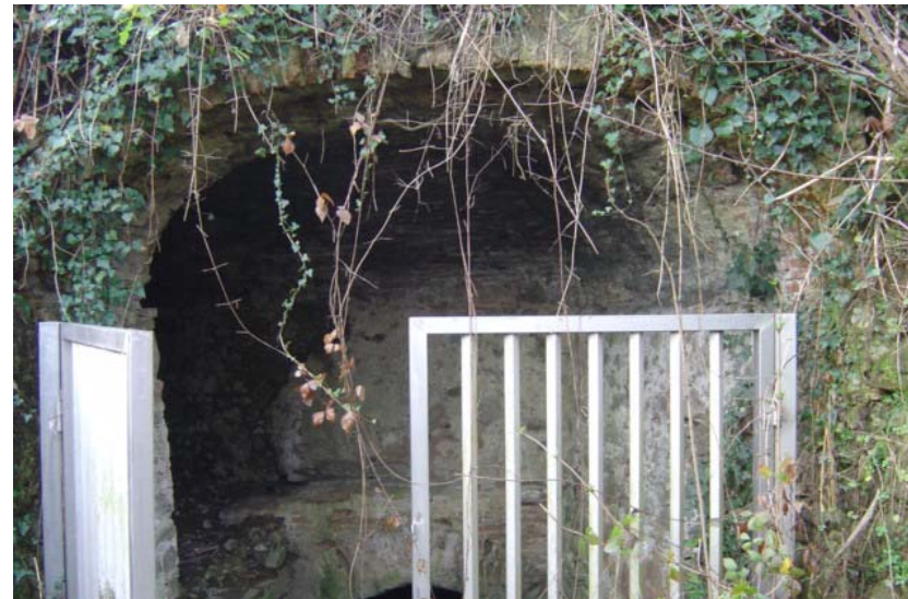
Foto 14 - F. Agnaccino: ingresso del sottoattraversamento del T. Agna
