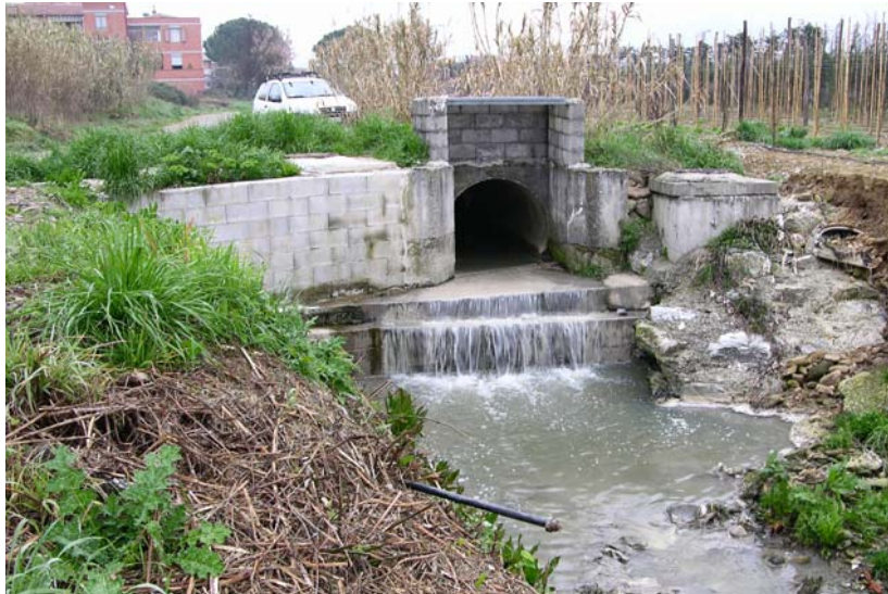
Foto 13 – F. Badia: sezione a chiusura del tratto tombato della foto 8 (sez. BA0014C_)
