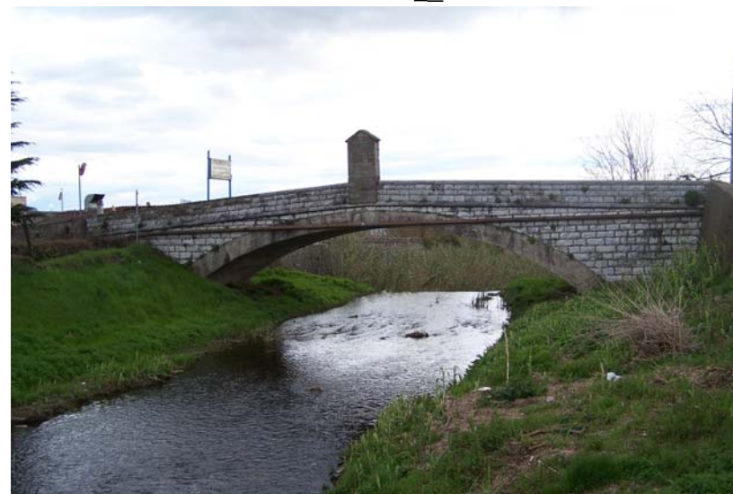
Foto 20- T. Agna: ponte su via Montalese visto da monte (sez. AG0013B_)
