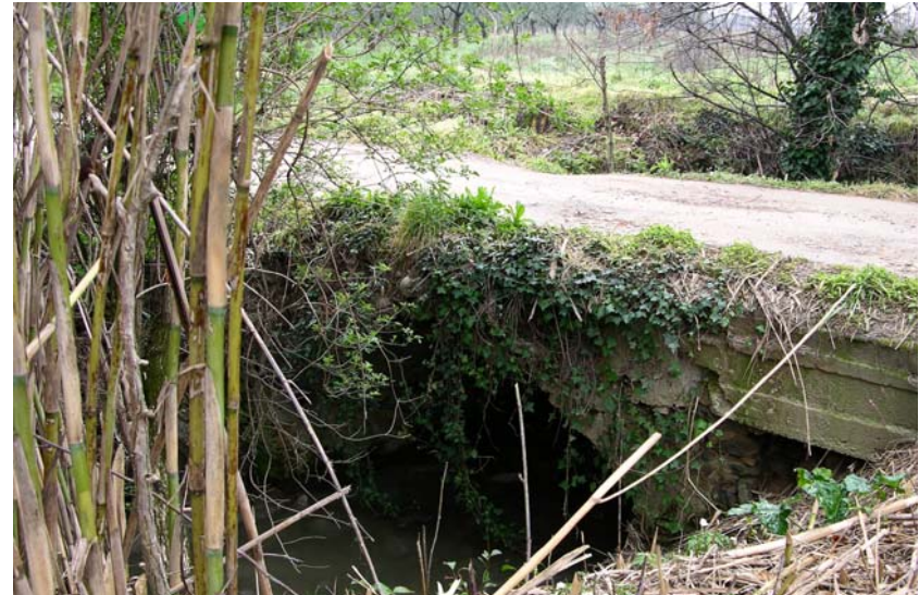
Foto 18 – F. Badia: attraversamento alla sezione BA0019B_ visto da monte
