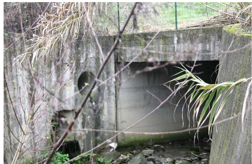
Foto 16- F. Badia: sezione a chiusura del tratto tombato alla sezione BA0017C_
