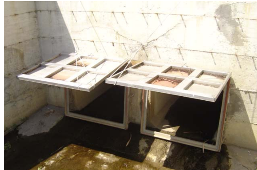
Foto 6 - F. Agnaccino: scarico di fondo della cassa di espansione
