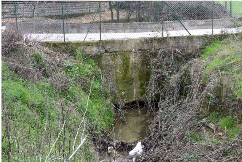
Foto 5 – F. Badia: ponte su via Fonte Bronia visto da valle (sez. BA0002C_)
