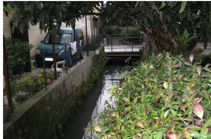
Foto 22 – F. Badia: tratto a monte della sezione BA0039B_
