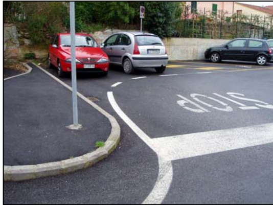
foto 5: parcheggio in via Garibaldi, nell'ambito urbano di Stazione. Non esiste un adeguato percorso pedonale di collegamento tra lo stallo per disabili (caratterizzato dalle strisce di colore giallo) e l'attraversamento per la piazza della Stazione (vedi foto succ.)
