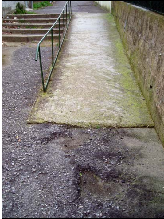
foto 9: particolare del percorso pedonale del Rio, nel Capoluogo. La superficie di calpestio si presenta, in molti tratti, in cattive condizioni di manutenzione, tali da costituire ostacolo alla mobilità.
