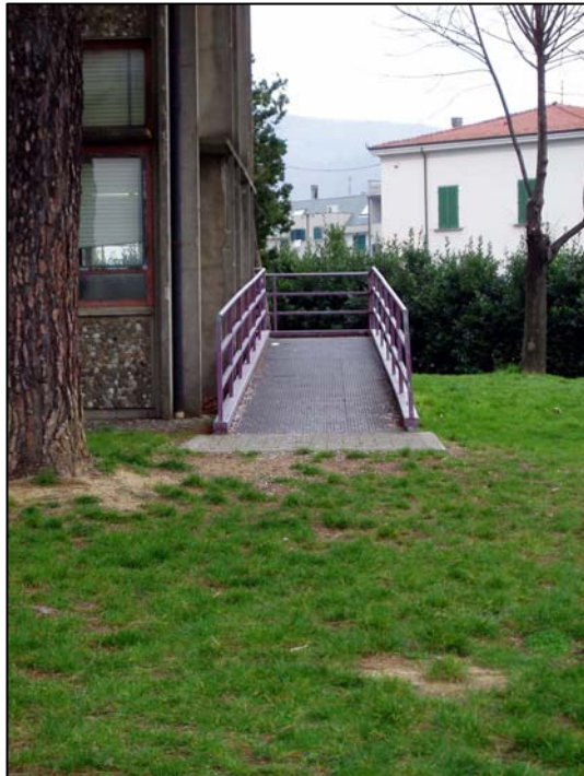
foto 4: scuola media in via Martin Luther King, nel Capoluogo. Particolare di una rampa priva del percorso pedonale di
