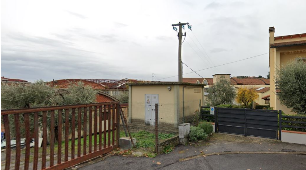
Linea aerea MT/BT in prossimità dell'accesso da via Brunelleschi
